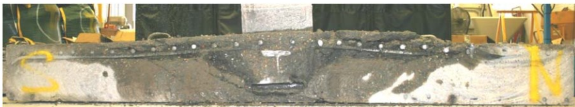
Рис. 10. Разрушение экспериментальной модели. Опыт с пластиной с поперечной арматурой (HS13-CT) [9]
