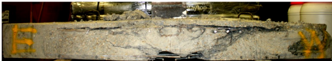
Рис. 14. Разрушение экспериментальной модели. Опыт без пластины с поперечной арматурой (HS13-0T) [9]
